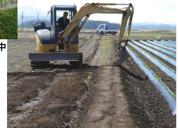
バックホウによる畦畔の嵩上げ
