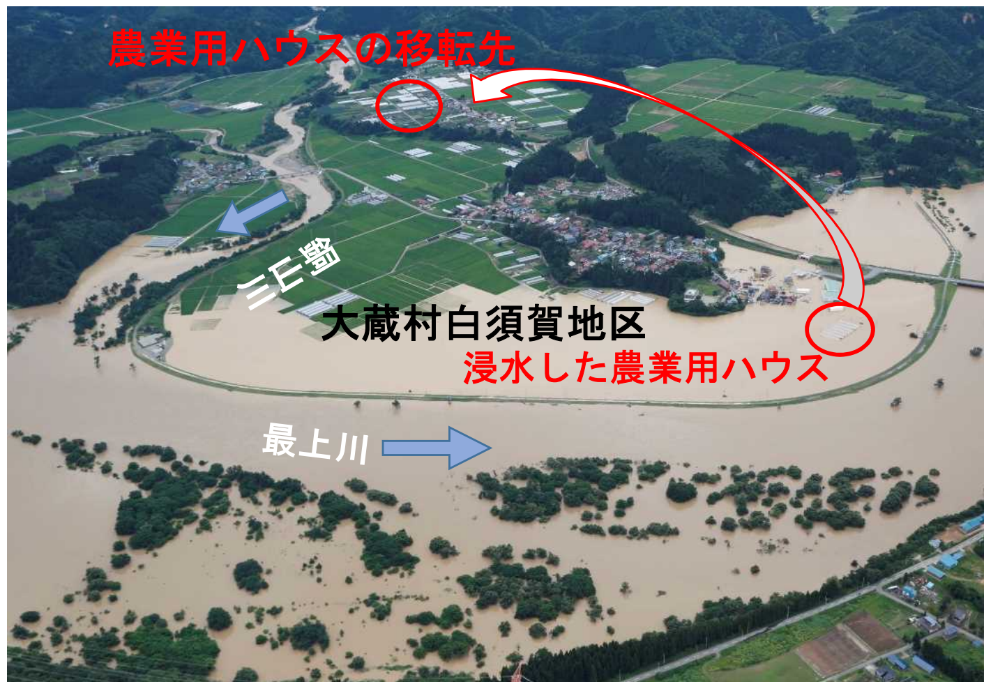
令和2年7月洪水により浸水した大蔵村白須賀地区
