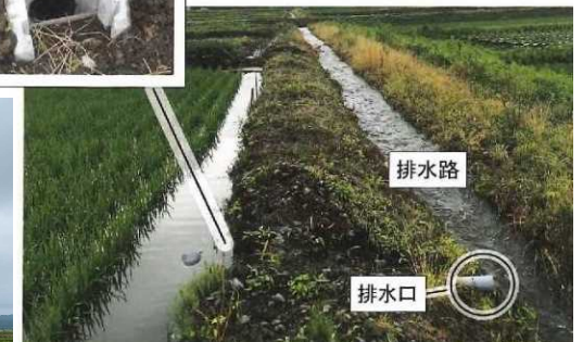
堰板による止水状況
