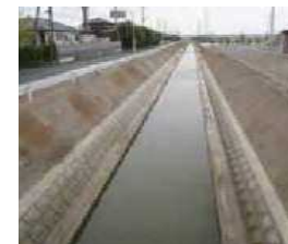
排水路の整備
