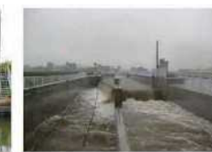
(排水分水ゲート)
