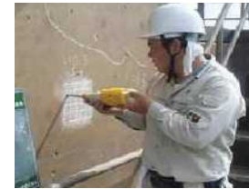
老朽化した施設の機能診断
