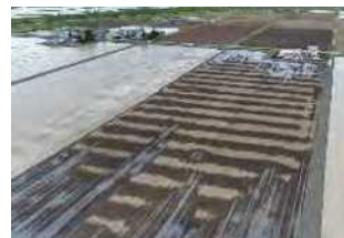
地下かんがいシステムの導入
