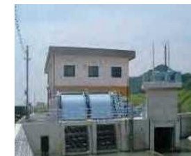
排水機場の整備
