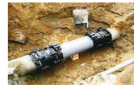
漏水防止のための整備
