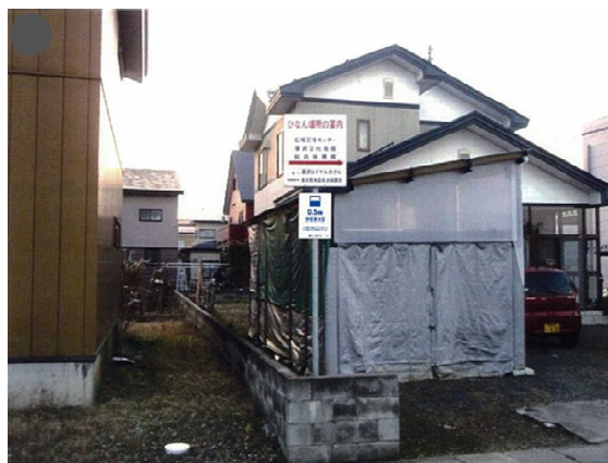
標識に設置した例（湯沢市）
