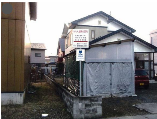
標識に設置した例（湯沢市）
