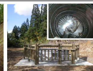
地すべり防止工
