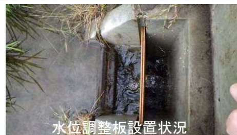
降雨後の排水状況(貯留効果確認)
