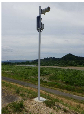
簡易型河川監視カメラ設置状況
