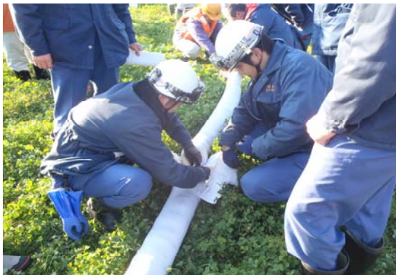
☆ オイルフェンスの接続 ☆
