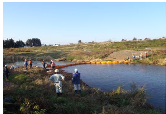
☆ オイルフェンスの設置 ☆
