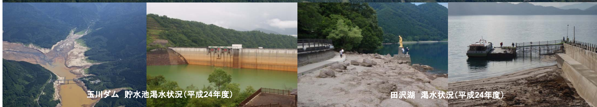
玉川ダム 貯水池渇水状況(平成24年度)
