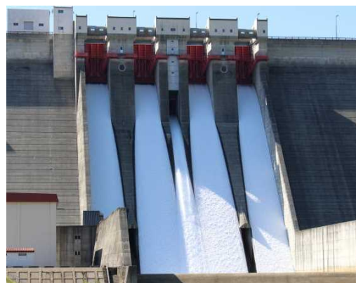
玉川ダムの試験放流の様子
