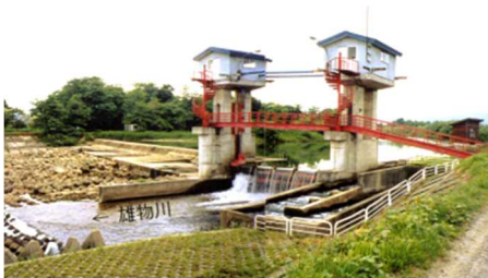
大久保頭首工（改築前）
