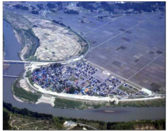
強首輪中堤（完成後）
