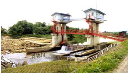
大久保頭首工（改築前）
