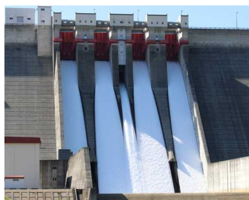
玉川ダムの試験放流の様子
