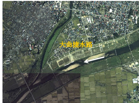
大曲捷水路完成後（平成22年）
