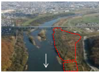
・河道掘削や樹木伐採
