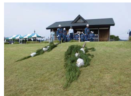
参考-2 仙北市水防訓練 (川倉工法・シート張り工法・木流し工法)
