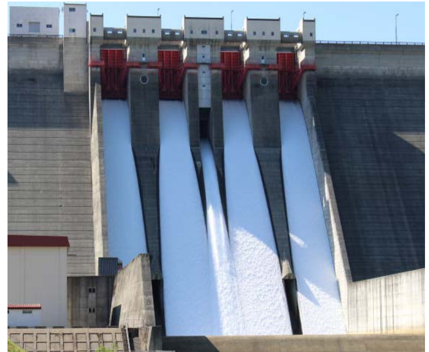
玉川ダム試験放流の様子
