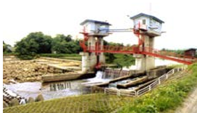
○大久保頭首工（改築前）
