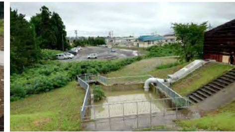
大曲・マスプロダクツ型排水ポンプによる排水作業
