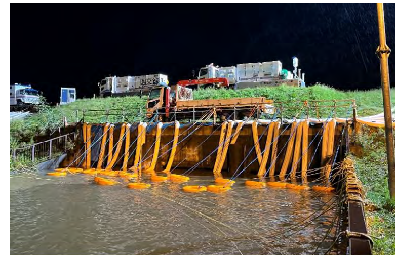
国・市の排水ポンプ車による排水活動
