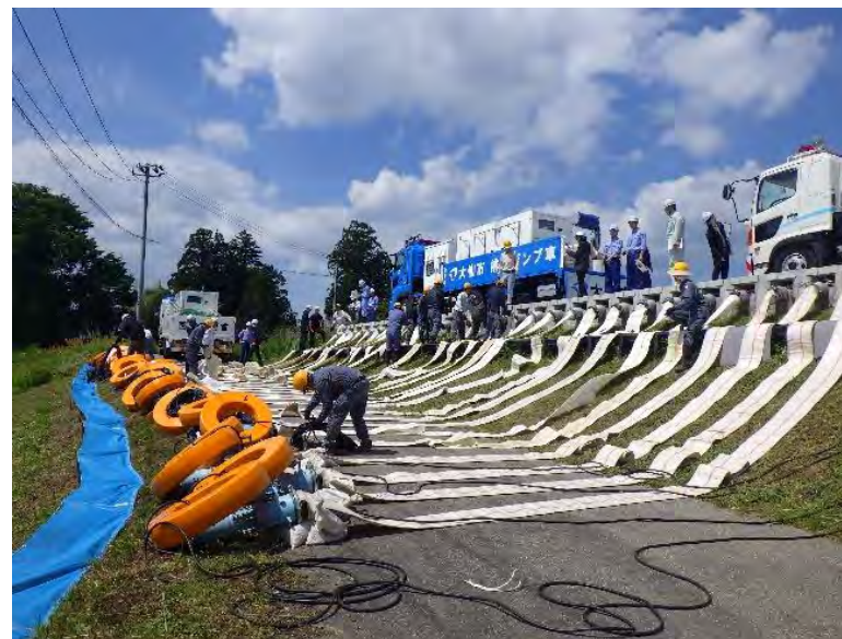
国土交通省・秋田県・大仙市による排水ポンプ車設置訓練状況
