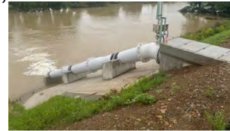
大曲・マスプロダクツ型排水ポンプによる排水作業
