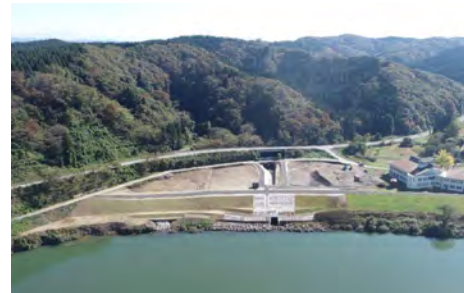
戸草沢地区 堤防・排水樋門整備状況
