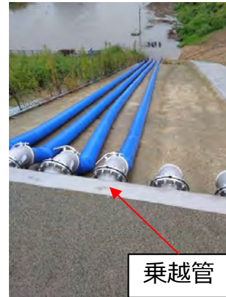
西仙北・大沢川樋門
