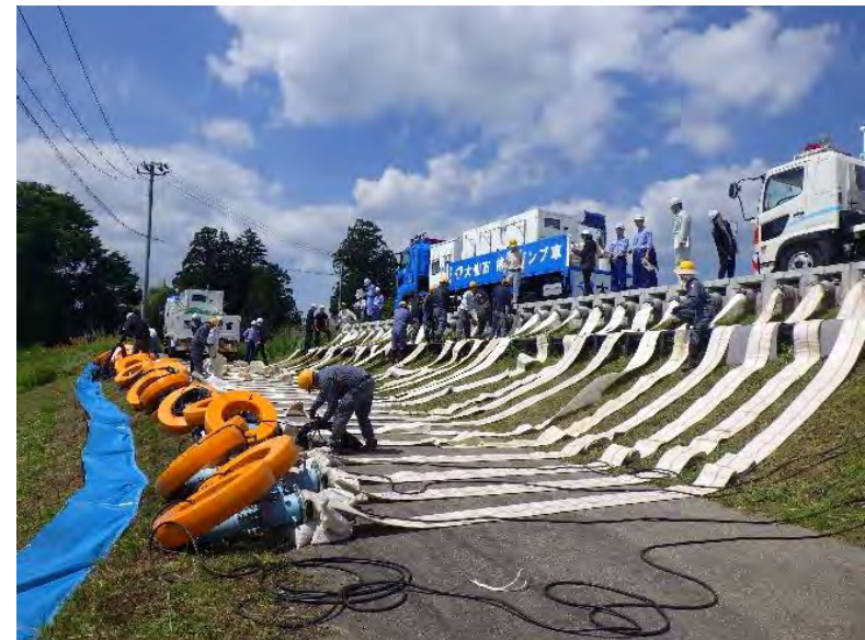
国土交通省・秋田県・大仙市による排水ポンプ車設置訓練状況
