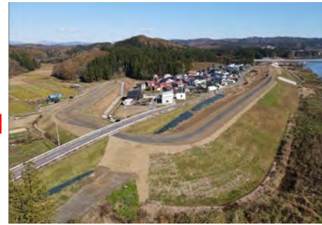
岩瀬湯野沢地区堤防整備状況
