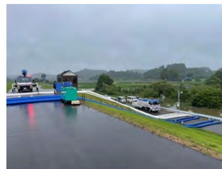
協和・沼館川樋門
