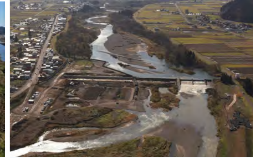
山田地区堰改築進捗状況 (令和6年12月2日撮影)
