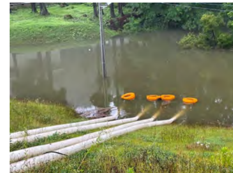
南外地域・西板戸樋門
