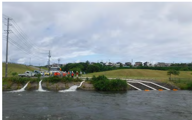
災害対策用排水ポンプ車による排水訓練
