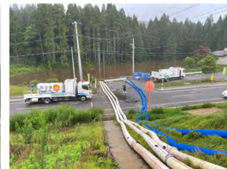
協和・小平沢樋門
