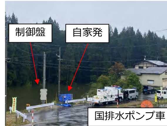
協和・小平沢排水樋門
