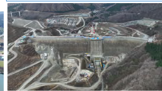
成瀬ダム 本体工事進捗状況 (令和6年11月27日撮影)
