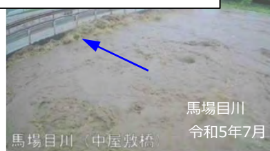
出水による被害状況
