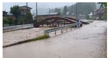
内川川の氾濫(内川湯ノ又地区)
