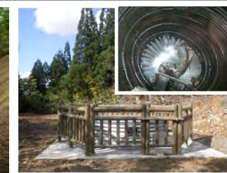
地すべり防止工
