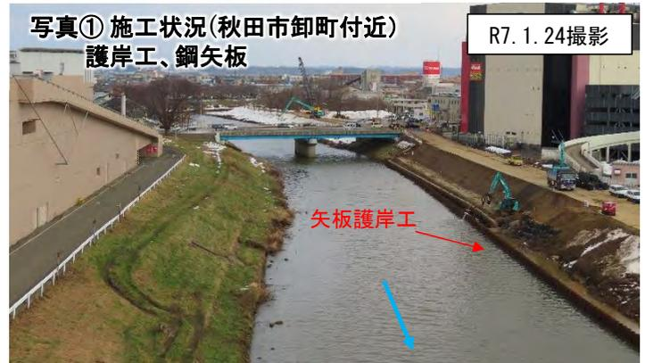
写真① 施工状況(秋田市卸町付近)
