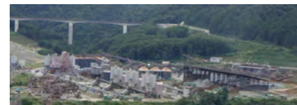
↑ 仮設備ヤード
