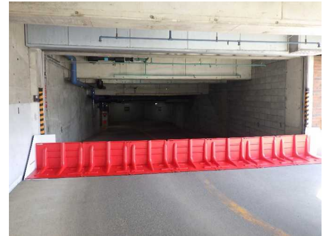
本庁地下駐車場入り口への「止水版」設置状況
