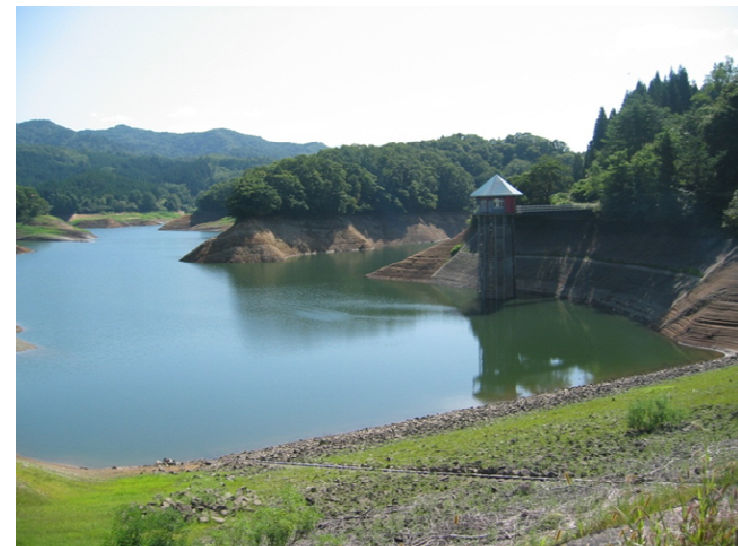
〔写真 相野々ダム〕
