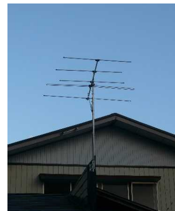
個別アンテナの設置
