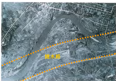
大曲捷水路改修工事中（昭和36年）
