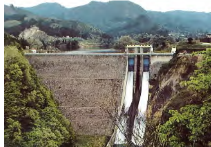
皆瀬ダム (昭和 38 年完成)
