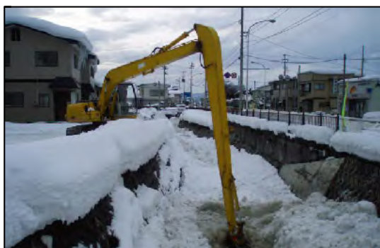
雪により閉塞した河川の復旧作業状況
