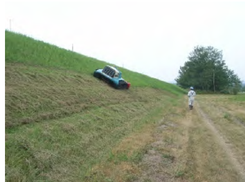
堤防除草作業状況
