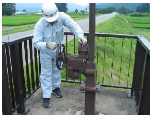
施設点検（樋門ゲート設備）の状況
