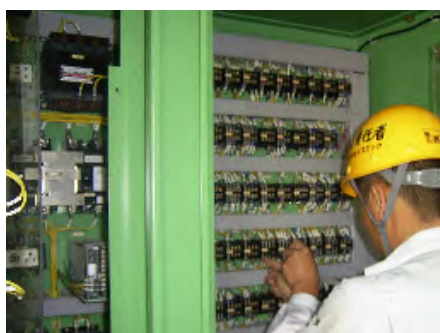
機側操作盤の点検状況
