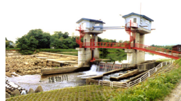
大久保頭首工（改築前）
