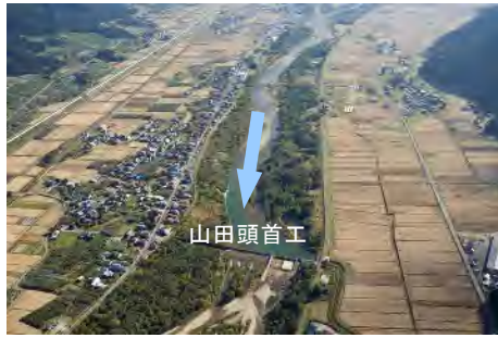
やまだ 山田頭首工周辺の樹木の繁茂状況
