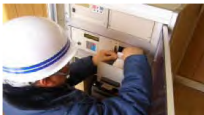
観測所保守点検状況
