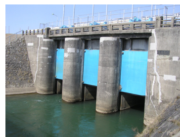
新屋水門（改築前）
