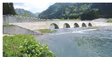
生保内川大暗渠砂防堰堤
