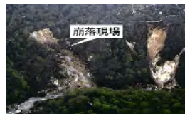
先達川被害状況（平成9年）
