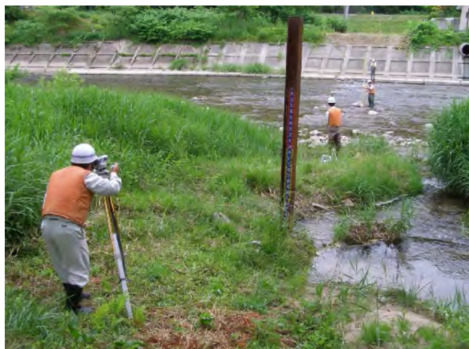
河川横断測量の様子
