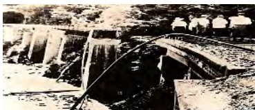
田沢湖線被害状況（昭和35年）
