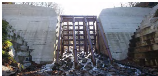
かにざわ 蟹沢第1砂防堰堤（平成22年12月完成）
