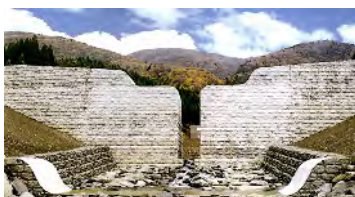
黒沢第1砂防堰堤
