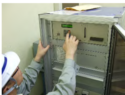
観測施設の点検状況
