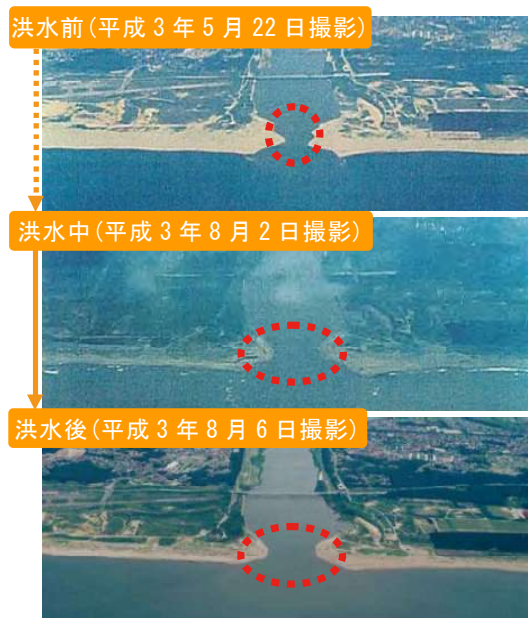
河口砂州の状況
