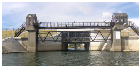
新屋水門（改築後）
