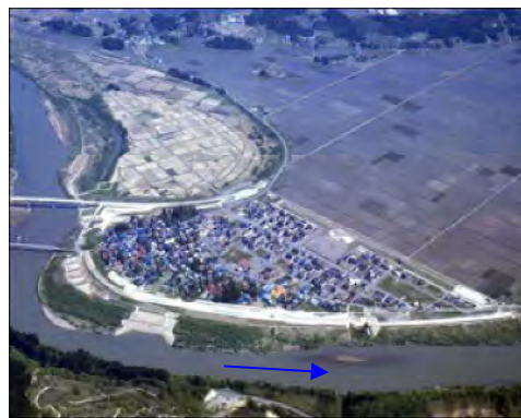
強首輪中堤（完成後）
