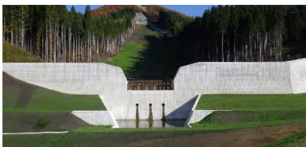
くよふつさわ 供養佛沢砂防堰堤（平成26年6月完成）
