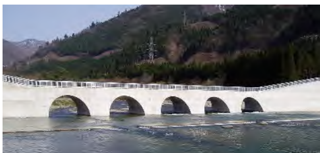
大暗渠砂防堰堤（平成18年2月完成）
