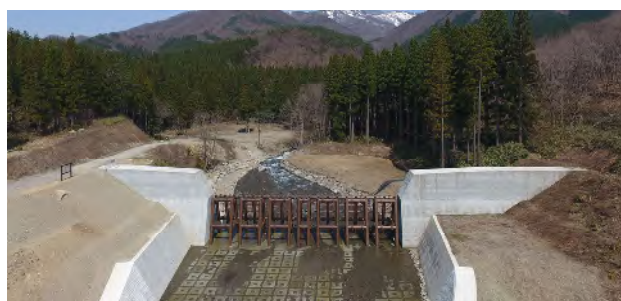
きたひのきないがわ 北檜木内川第1砂防堰堤（平成30年2月完成）
