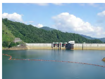
玉川ダム 流木止施設
