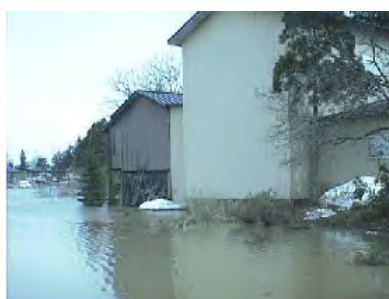
平成12年4月洪水での内水被害状況（大仙市角間川）
