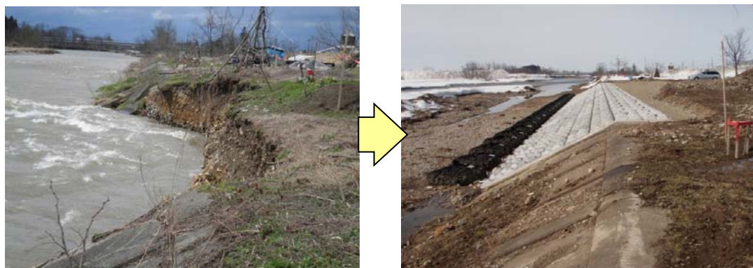
護岸の損傷
