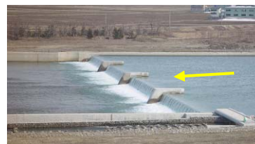
大久保堰（改築後）
