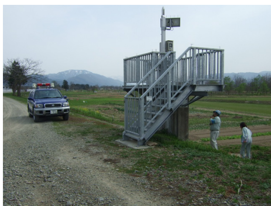
河川巡視(平常時)の状況
