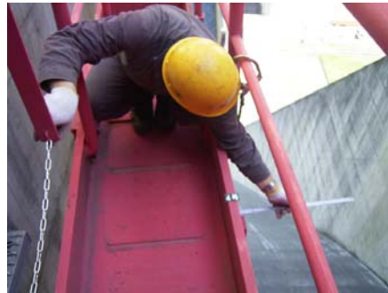
放流設備点検状況
