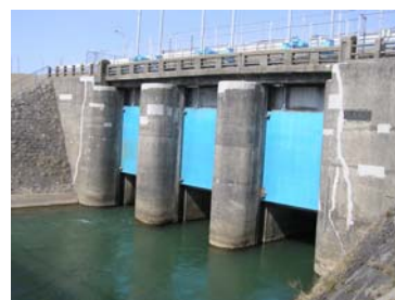
新屋水門（改築前）
