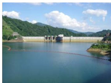
玉川ダム 流木止施設
