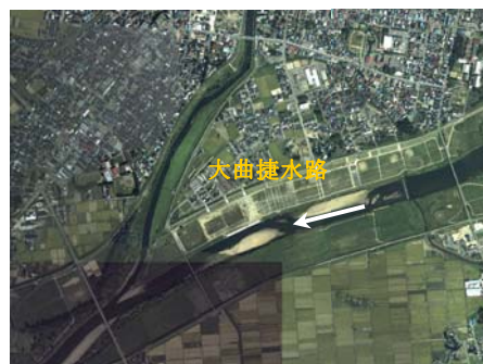
大曲捷水路完成後（平成22年）
