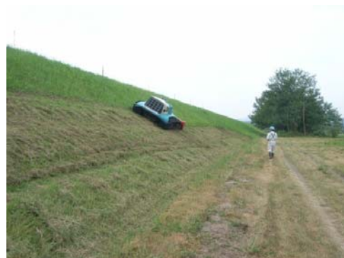
堤防除草作業状況
