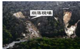
先達川被害状況（平成9年）
