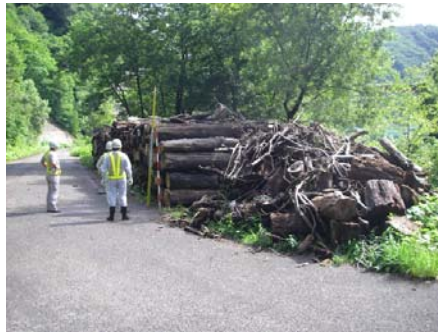
流木処理の状況
