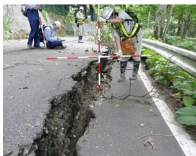
TEC-FORCE の派遣状況 岩手県沿岸北部地震 (平成 20 年 7 月 24 日)
