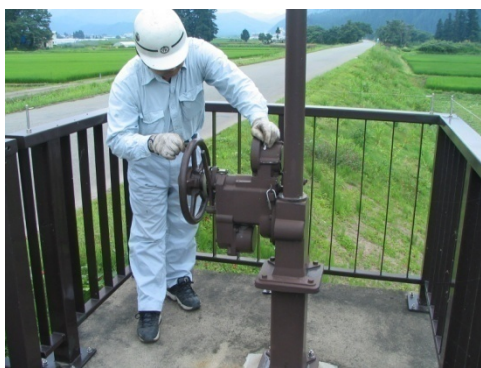
施設点検（樋門ゲート設備）の状況
