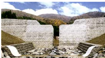
黒沢第1砂防堰堤
