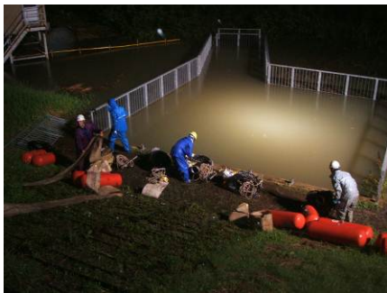
浜町排水ピット
