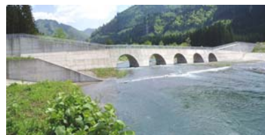
生保内川大暗渠砂防堰堤
