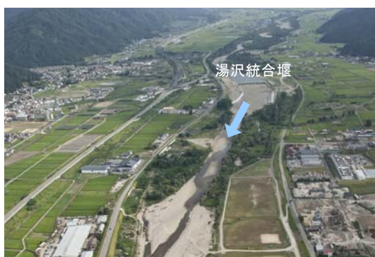
雄物川上流部の砂州の状況
