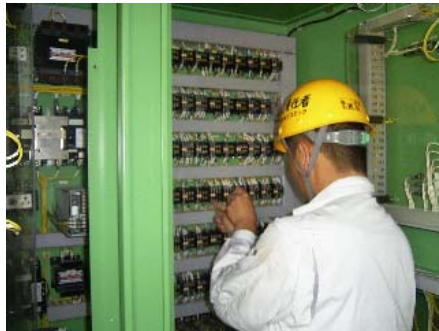
機側操作盤の点検状況
