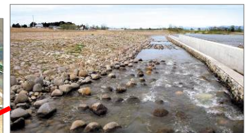
粗石付き斜路式魚道
