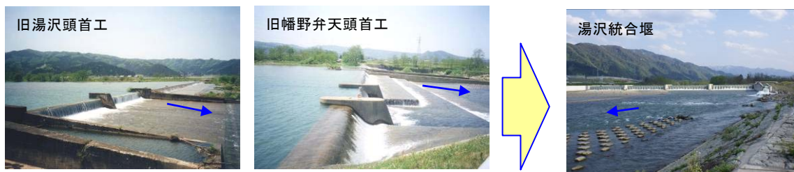
湯沢頭首工改修前後の施設状況
