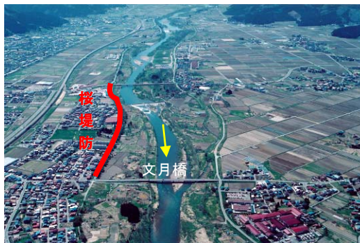
文月橋上流の桜堤防区間
