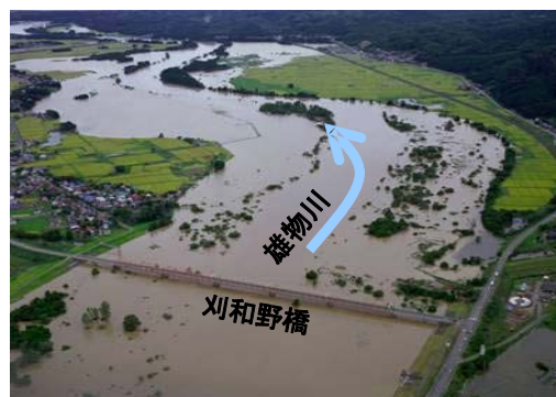
平成 19 年 9 月洪水写真 (刈和野橋地点)
