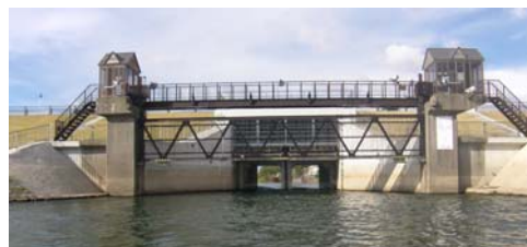
新屋水門（改築後）
