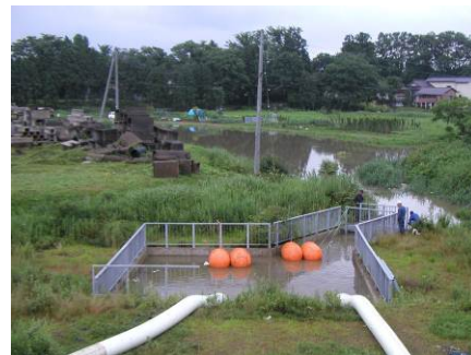
角間川排水ピット
