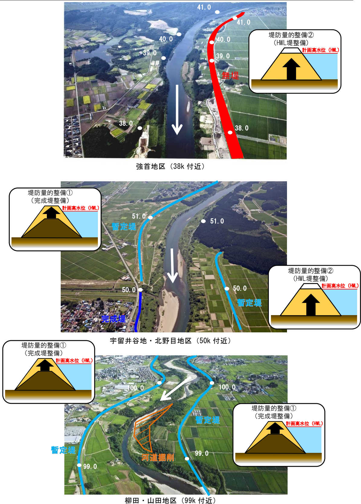
図 5-6 雄物川 堤防整備箇所为例
