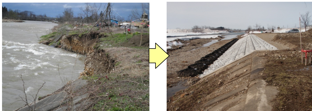
護岸の損傷
