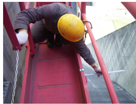
放流設備点検状況
