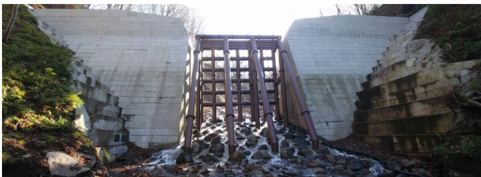
かにざわ 蟹沢第1砂防堰堤(平成22年12月完成)
