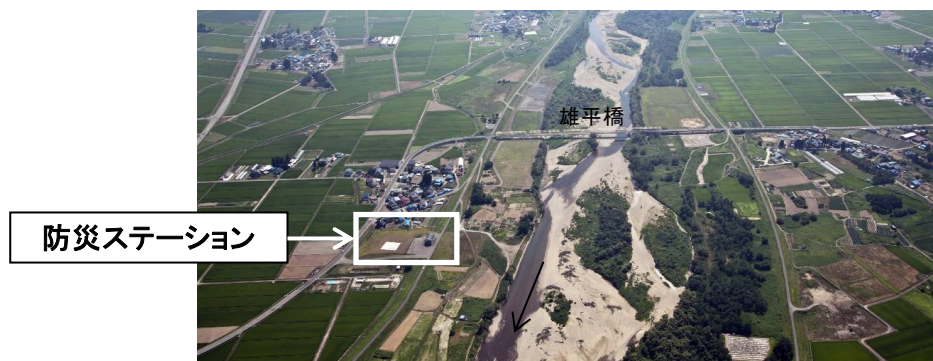
十文字防災ステーション（皆瀬川右岸：横手市）
