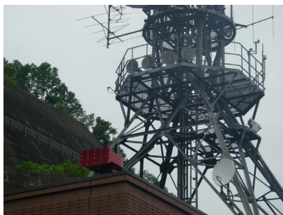
玉川ダム 放流警報施設
