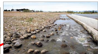
粗石付き斜路式魚道
