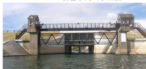
新屋水門（改築後）
