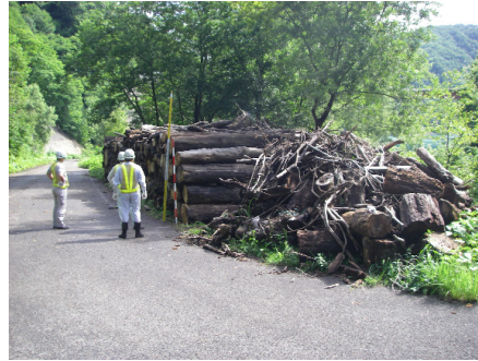
流木処理の状況
