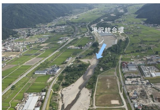
雄物川上流部の砂州の状況
