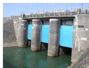
新屋水門（改築前）
