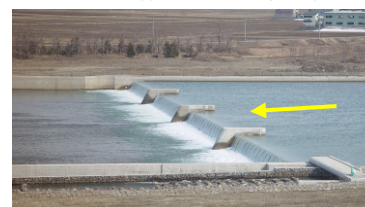
大久保堰（改築後）
