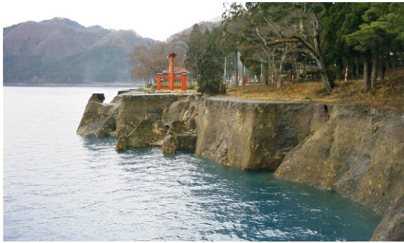
水位の低下により悪化した景観
