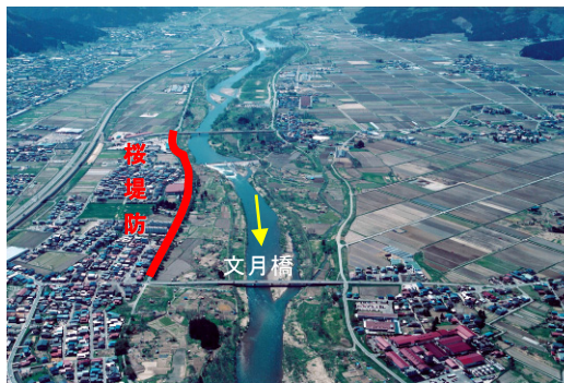
文月橋上流の桜堤防区間
