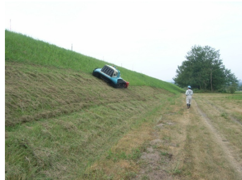
堤防除草作業状況
