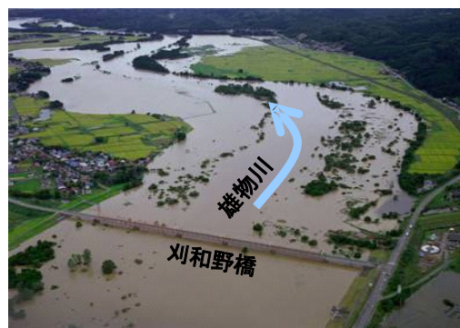
平成 19 年 9 月洪水写真 (刈和野橋地点)
