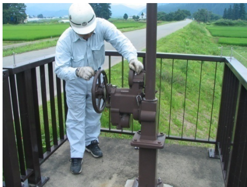
施設点検（樋門ゲート設備）の状況
