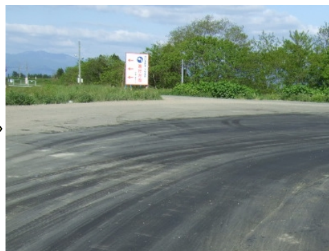
堤防の天端舗装補修後の状況
