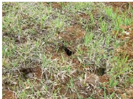
堤防変状状況（車輛による損傷、モグラ穴）
