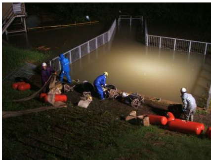
浜町排水ピット
