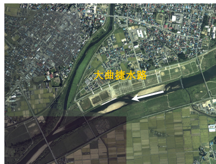
大曲捷水路完成後（平成22年）
