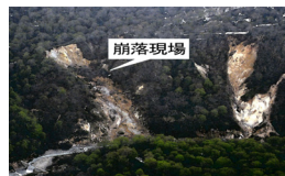
先達川被害状況（平成9年）
