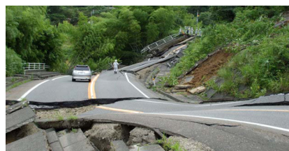
被災状況調査
