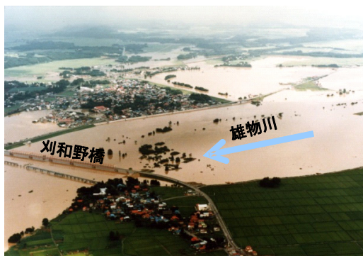
昭和 62 年 8 月洪水写真 (刈和野橋地点)
