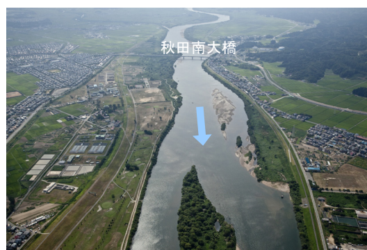
雄物川下流部の砂州の状況
