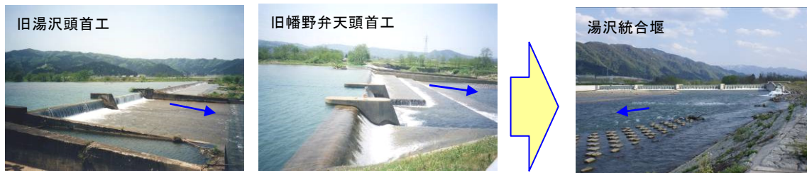
湯沢頭首工改修前後の施設状況
