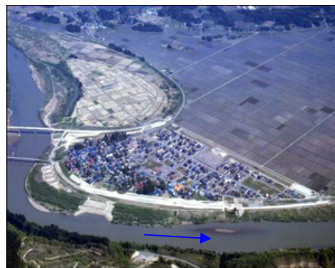
強首輪中堤（完成後）
