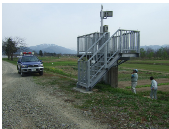
河川巡視(平常時)の状況
