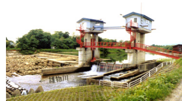
大久保頭首工（改築前）
