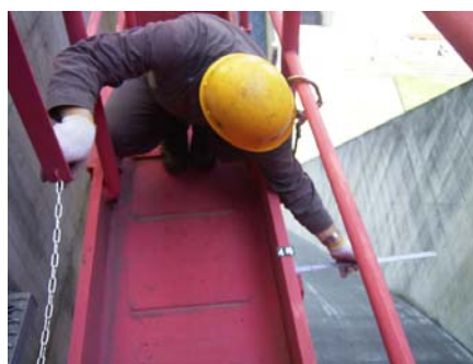
放流設備点検状況
