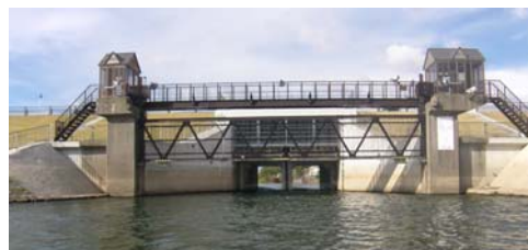
新屋水門（改築後）
