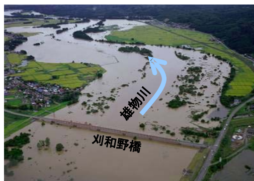
平成 19 年 9 月洪水写真 (刈和野橋地点)
