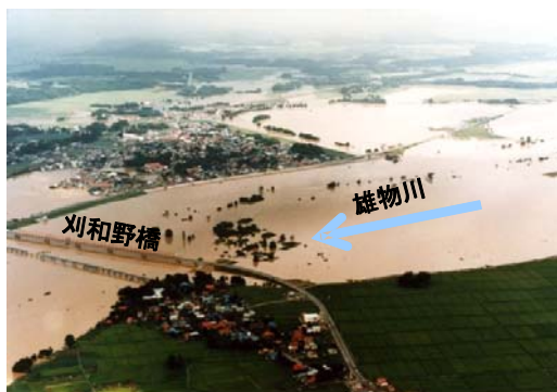
昭和 62 年 8 月洪水写真 (刈和野橋地点)
