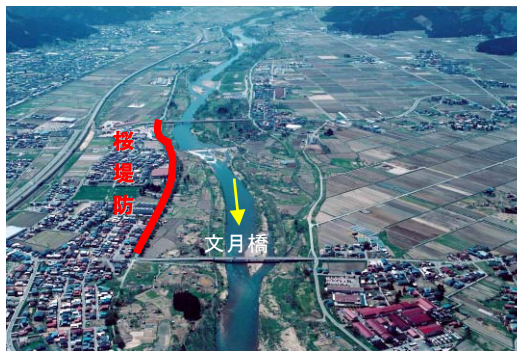
文月橋上流の桜堤防区間
