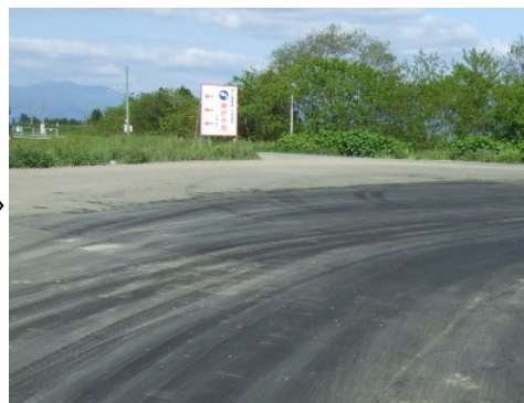
堤防の天端舗装補修後の状況
