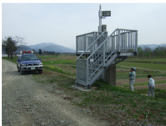
河川巡視(平常時)の状況
