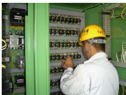
機側操作盤の点検状況
