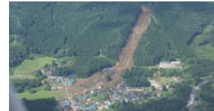
供養佛地区被害状況（平成25年）
