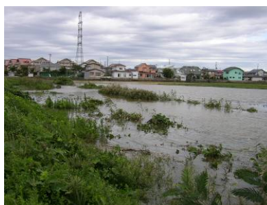
平成19年9月洪水での内水被害状況（秋田市 よつごや 四ツ小屋地区）
