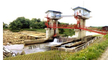
大久保頭首工（改築前）
