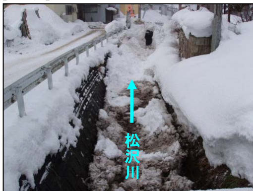
消流雪用水の通水実施状況（湯沢市松沢川）
