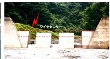
土砂移動検知センサー
