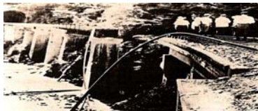
田沢湖線被害状況（昭和35年）
