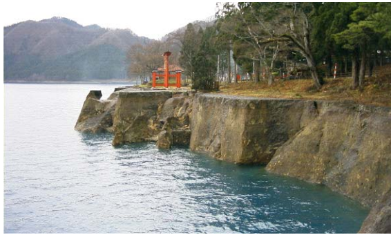
水位の低下により悪化した景観
