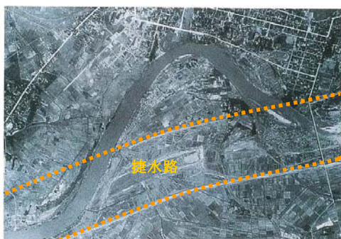
大曲捷水路改修工事中（昭和36年）
