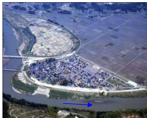
強首輪中堤（完成後）
