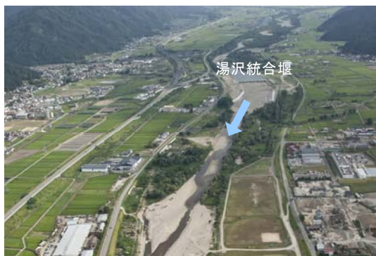
雄物川上流部の砂州の状況
