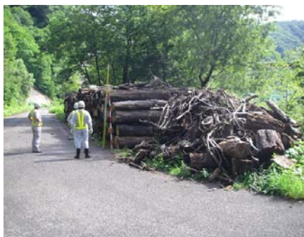
流木処理の状況
