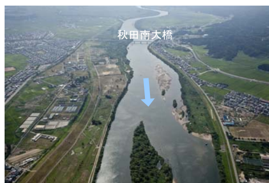
雄物川下流部の砂州の状況
