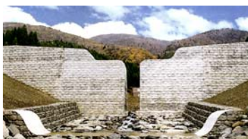
黒沢第1砂防堰堤
