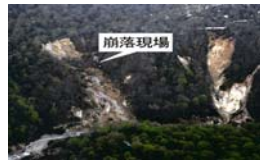
先達川被害状況（平成9年）
