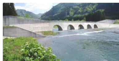
生保内川大暗渠砂防堰堤
