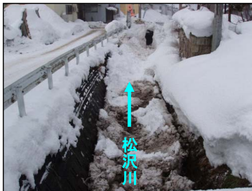
消流雪用水の通水実施状況（松沢川）
