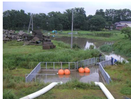
角間川排水ピット
