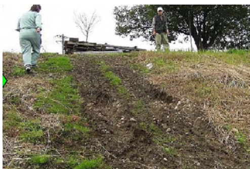
堤防変状状況（車輛による損傷、モグラ穴）
