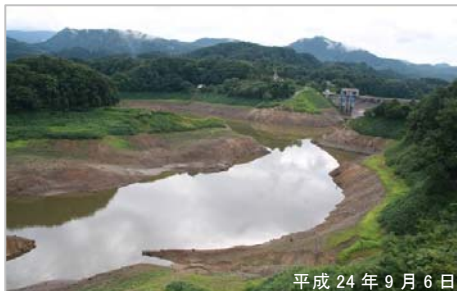
⑦ 皆瀬ダム貯水池の状況 (平成 24 年 9 月 : 湯沢市)
