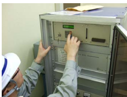
観測施設の点検状況
