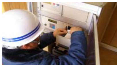
観測所保守点検状況
