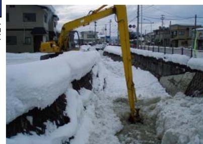
雪で閉塞した中小河川の復旧作業状況
