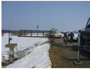
樋管の修繕 (老朽化した管理橋の更新)
