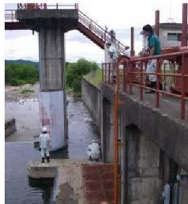
河川管理施設の点検
