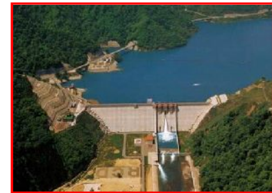
玉川ダム(H2年完成)
