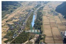
山田頭首工周辺の樹木の繁茂状況
