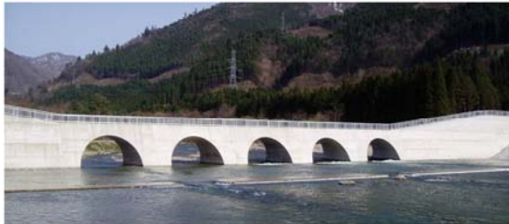
大暗渠砂防堰堤 (平成18年2月完成)
