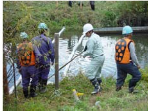
オイルフェンス設置訓練実施状況
