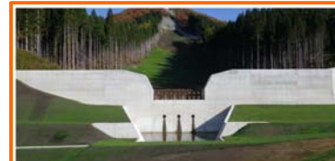
供養佛沢砂防堰堤 (平成26年6月完成)
