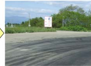
堤防の天端舗装補修後の状況
