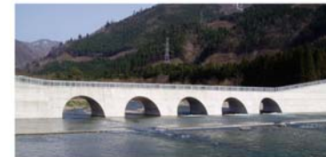
大暗渠砂防堰堤 (平成18年2月完成)
