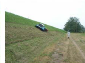
堤防除草作業状況
