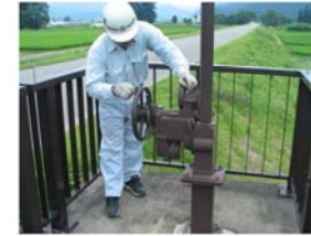
施設点検（樋門ゲート設備）の状況
