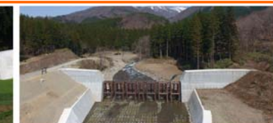
北榎木内川第1砂防堰堤 (平成30年2月完成)
