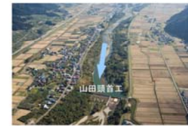
山田頭首工周辺の樹木の繁茂状況
