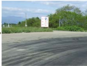
堤防の天端舗装補修後の状況
