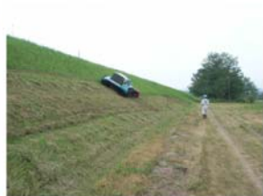
堤防除草作業状況
