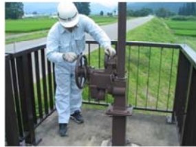
施設点検（樋門ゲート設備）の状況
