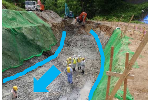
川の増水によって道路が削り取られたので、川の位置を変える工事をしています
