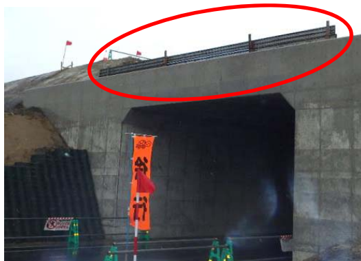
▲カルバートボックス天端に市道への転石防止のために固い素材で幅木設置
