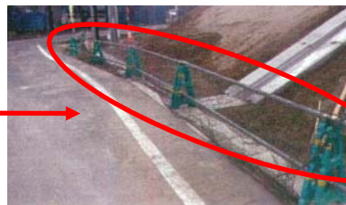
▲市道と法尻の境に転石防止としてネットを設置した
