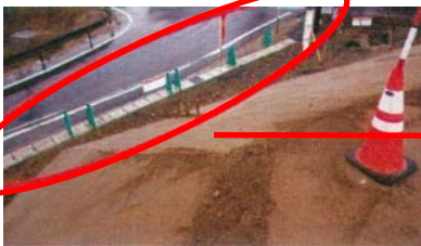
▲市道と法尻の境に転石防止としてネットを設置した
