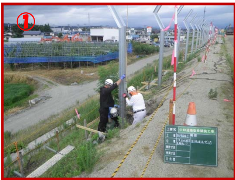
↑防雪柵支柱建て込みからパネル設置完了まで
