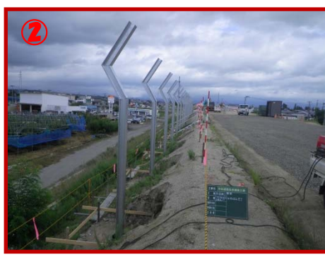
↑防雪柵支柱建て込みからパネル設置完了まで
