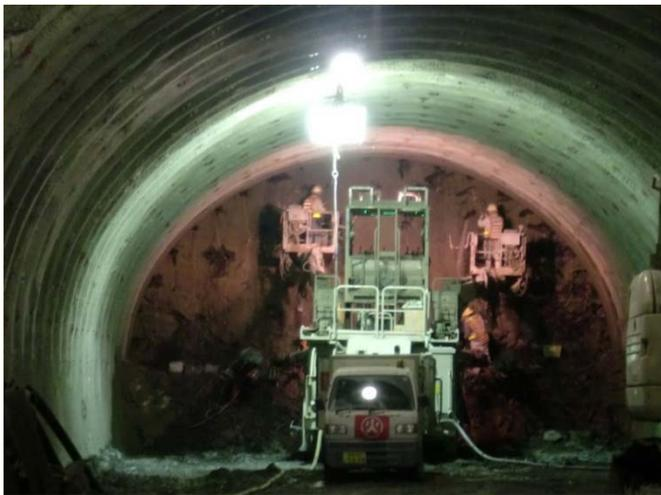
←ドリルジャンボで穴を開け、火薬を詰め爆破に向け作業している様子
