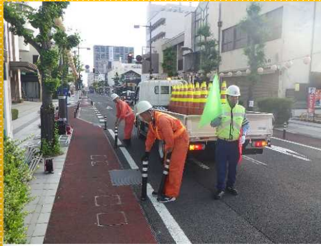
②取り外し中 一つ一つ人の手で取り外していきます。通行の妨げにならないよう、早朝に行います。
