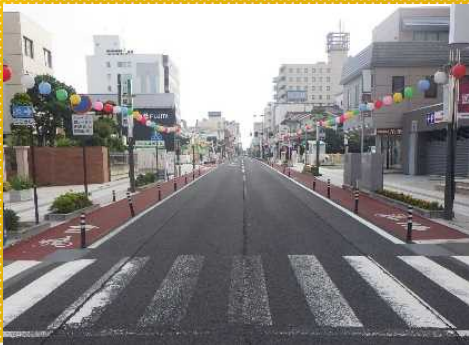
①取り外し前 車道と自転車道の上にポールがあります。
