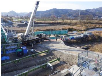
工場で製作された橋桁を現地に搬入し、ある程度の大きさに地上で組み立てた後
