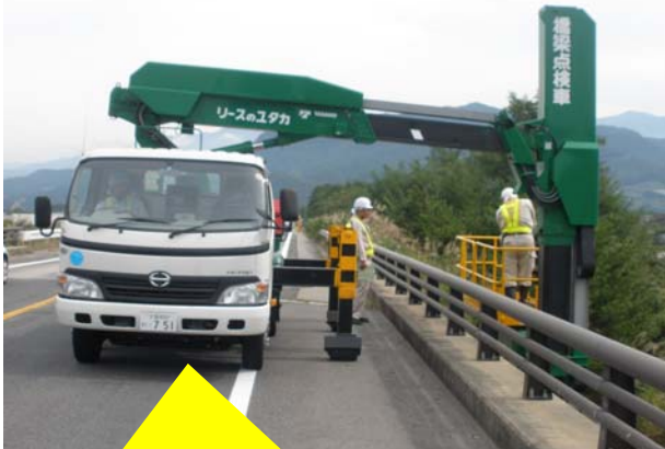
橋梁点検車を使用し、目視点検を行っているところです。
