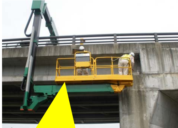
橋梁点検車を使用することにより、橋梁下面に入るのが困難な場所（河川内等）でも点検を行うことができます。
