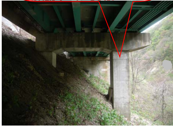
補強前の第二赤滝橋の橋脚（P1）です。橋脚幅は1.4mでした。
