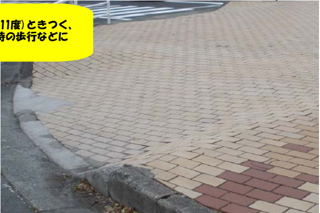
補修後の歩道状況です。 すり付け勾配は約5%（3度）と緩勾配になり、 車いす使用者が登坂可能に補修しました。
