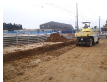
市道部の盛土状況 (掘削した土砂を活用)
