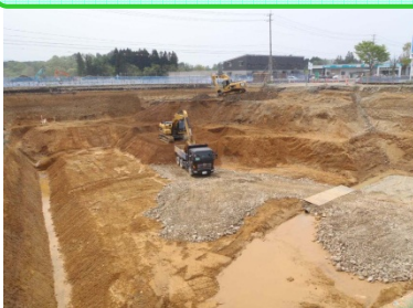
掘削状況 (ダンプ約3,000台の土を搬出)
