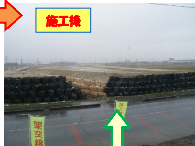
盛土が崩れないように大型土のうで抑えています
