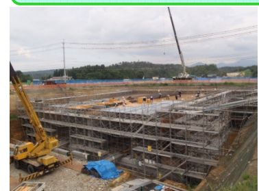
頂板部型枠・支保工組立状況 (頂板部とは梁の部分)
