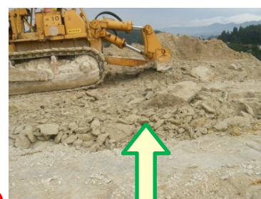
山が硬いので、リッパ(爪)の付いたブルドーザで破砕します
