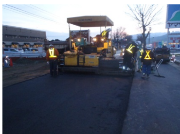
市道南原大石田線の舗装状況 (11/30に本線切替)
