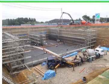
底部コンクリート打設状況 (1回の打設で生コン車約120台分)
