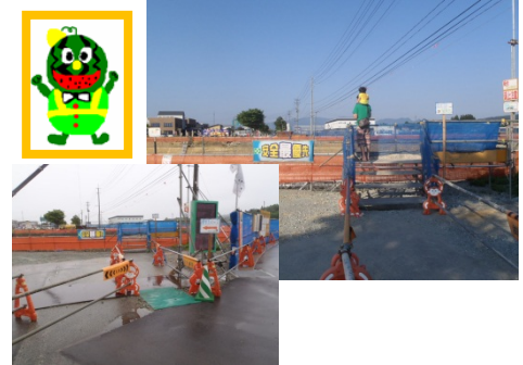
現場見学スペースの設置 (誰でも現場が見れる場所)
