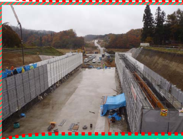
（左写真）尾花沢市丘陵部、擁壁工工事の状況です。（北側より南側を望む） 奥に臈気川橋及び切土部（大石田町鳥木沢地内）が見えます。 （右写真）尾花沢市丘陵部、水路付替用箱形トンネル工事の状況です。 左側2車線の整備を進めます。（南側より北側を望む）
