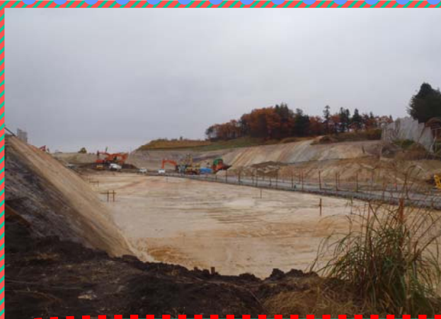
大石田ゴルフ場東側南斜面の切土状況です。掘削した土砂は東根IC付近や村山市の盛土場へ運搬しております。（大石田町今宿地内）
