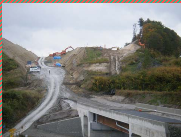
（左写真）大石田ゴルフ場東側北斜面の切土状況です。手前に見えるのが五十沢川橋で工事が完成し土運搬路として使用しております。（大石田町今宿地内） （右写真）切土箇所から尾花沢市方向を見た写真です。道路の形が判ると思います。
