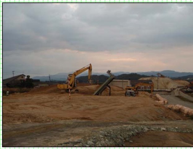
切土場（尾花沢市・大石田町）より土砂を運搬し、盛土を施工中です。 （左：村山市河島地内 右：村山市本飯田地内）
