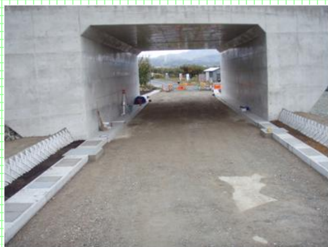
市道上の道路函渠工（工事が完了し車道の通行が可能）や水路函渠工を施工中です。 （左：村山市本飯田地内 右：村山市土生田本飯田地内）
