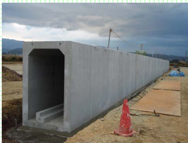
市道上の道路函渠工（工事が完了し車道の通行が可能）や水路函渠工を施工中です。 （左：村山市本飯田地内 右：村山市土生田本飯田地内）
