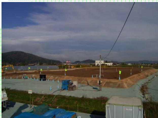
村山IC付近の軟弱地盤対策工を施工中です。（村山市河島地内）
