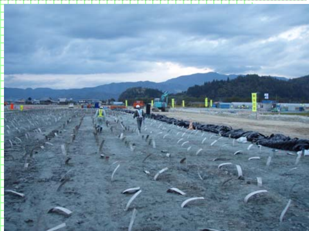
村山IC付近の軟弱地盤対策工を施工中です。（村山市河島地内）
