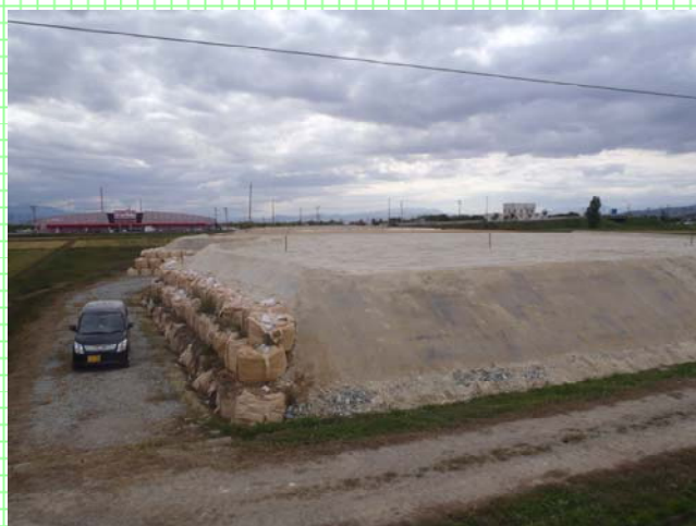
切土場（尾花沢市・大石田町）より土砂を運搬し、盛土を施工中です。 （左：村山市河島地内 右：村山市本飯田地内）
