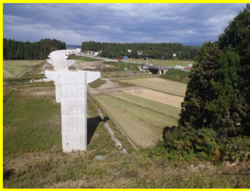
【野黒沢高架橋 L=598m】（工事中） 野尻川・県道荻袋正厳線・国道13号を横断 平成25年度に上部工の桁を架設する予定です。（参考）すいかの名産路14号で桁の架設を紹介
