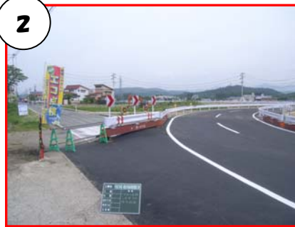
2 迂回路の設置完了 工事期間中も、一般車両が通行できるように迂回する道路を設置しました。
