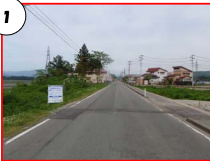
1 工事着工前 最初に県道を迂回させる工事にとりかかります。
