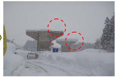
【事例紹介① 野黒沢高架橋(尾花新)】 構造物の下を国道13号が通っており交通量が多く、人力で排雪するには危険であることから、電熱シートを設置し雪を溶かしています。○のとおり、雪の量が少なくなっております。
