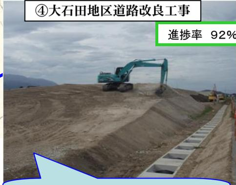
【東根市大堀地区】中央道の盛土及び市道の間に側溝を設置しております。
