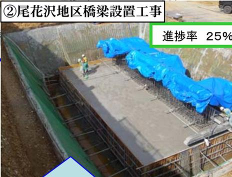
【尾花沢市尾花沢 県道部】掘削が完了し、橋梁の基礎部(フーチング部)にコンクリートを打設しております。
