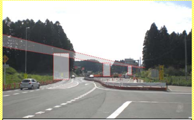
北側から見た現場
