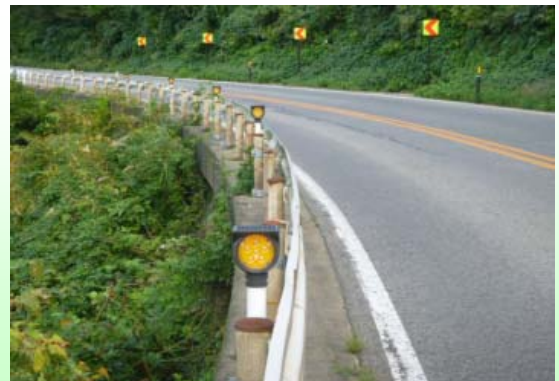
▲自発光式視線誘導標を設置しました
