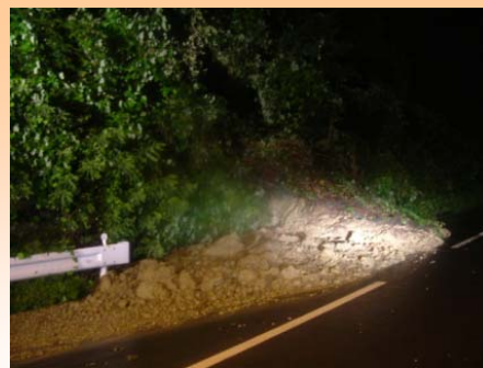
② 法面崩落 181.25kp上り 真室川町及位地内
