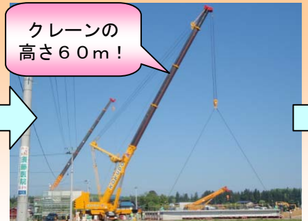
超大型クレーン(650t吊)で橋桁を架設します
