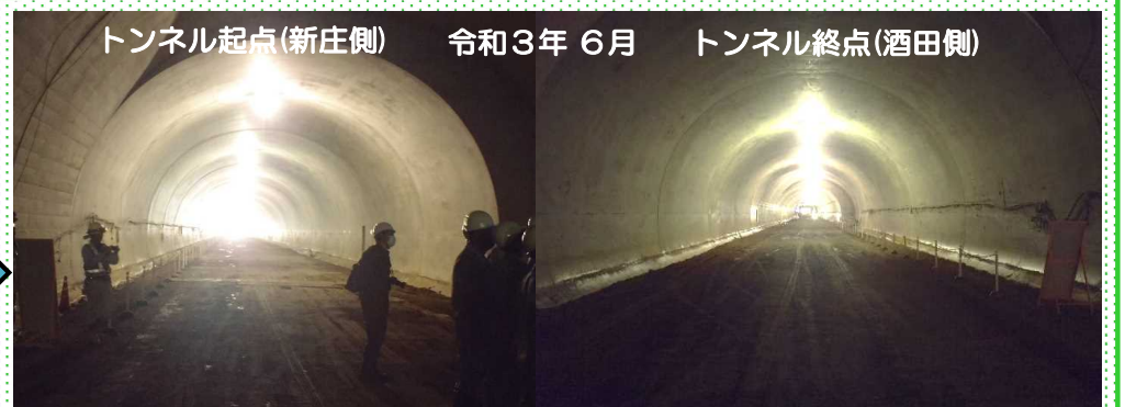
内壁のコンクリート打設もほとんど終わり、一部を残すのみとなりました。このトンネル工事は、今年の9月で終了予定となります。令和4年度の開通に向け、舗装工事や設備工事等の作業を進めています。
