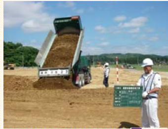
ダンプトラックで銚川から盛土の材料の土砂を搬入しています。
