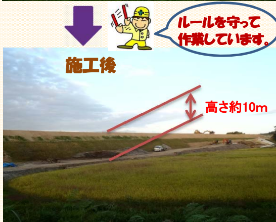
一層の高さ30cmピッチで盛土の作業をしています。
