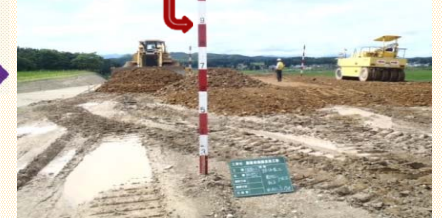
一層の高さ30cmピッチで盛土の作業をしています。
