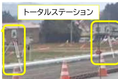
この2台の機械が作業本体の機械にデータを送り、制御しています。
