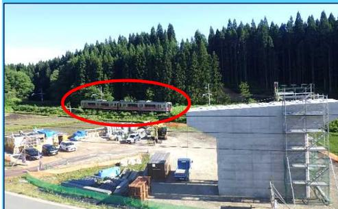
現場のすぐ隣をJR奥羽本線が走っているため、クレーンの転倒やシートが路線に飛んでいかないように気を付けています。
