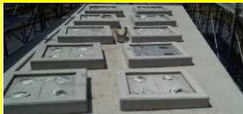
A2橋台・P2橋脚ともに箱型の橋桁が乗る台座がたくさんありました。P2橋脚では12個×2列で24個もありました。コンクリートが入らないようにする円柱型の型枠の設置は全部で96本にもなり、時間がかかりました。
