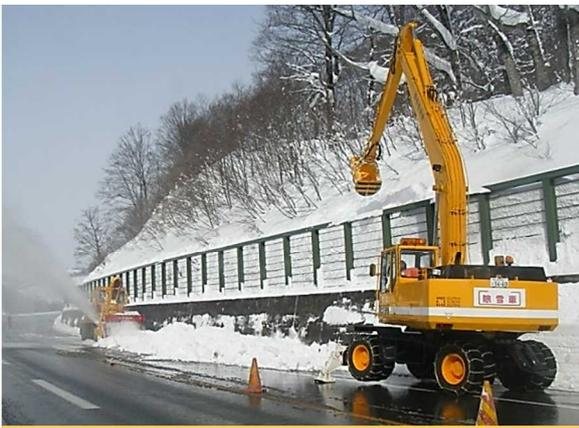
雪庇処理車で雪崩防止柵の背面にポケットを作り、ロータリ除雪車で遠くへ飛ばします
